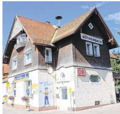
Das Bahnhofsgebäude gehört der Gemeinde. Fotos: Olaf Winkler (Archiv)
