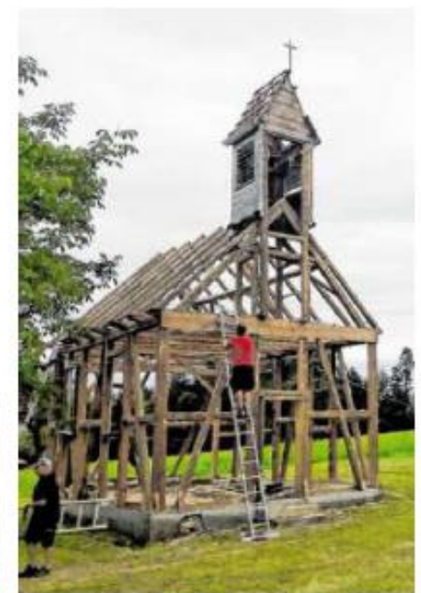
Schritt für Schritt haben fleißige Helfer die Kapelle im Opfenbacher Ortsteil Litzis abgebrochen. Der Neubau wird im kommenden Jahr entstehen.
